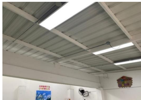
Fotografía 2. Verificación en sitio de la estructura instalada para el soporte de la cubierta corresponde a la ejecución del ítem 2.5.2. "Suministro e instalación de estructura metálica. Frente IED Salitre sede B.
