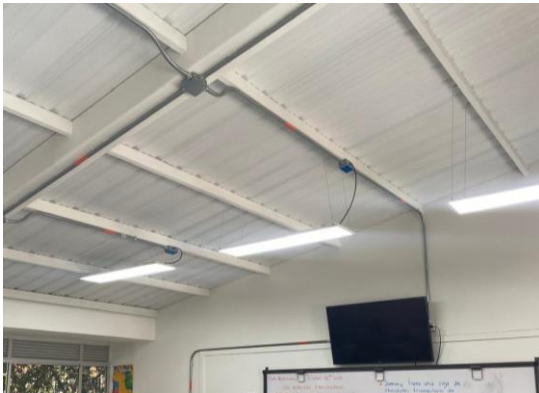
Fotografía 3. Verificación en sitio de la estructura instalada para el soporte de la cubierta correspondiente a la ejecución del ítem 2.5.2. "Suministro e instalación de estructura metálica. Frente IED La Gaitana sede B.
