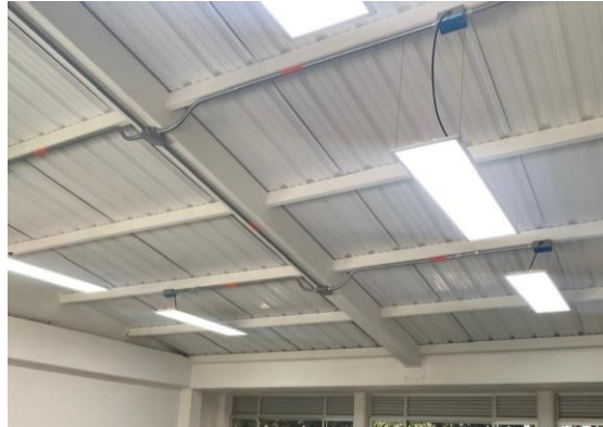
Fotografía 4. Verificación en sitio de la estructura para el soporte de la cubierta correspondiente a la ejecución del ítem 2.5.2. "Suministro e instalación de estructura metálica. Frente IED La Gaitana sede B.
