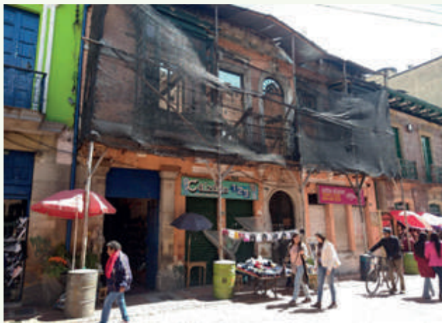
Foto 12. Fuente SCR D Fachada principal de un inmueble localizado en La Candelaria.
