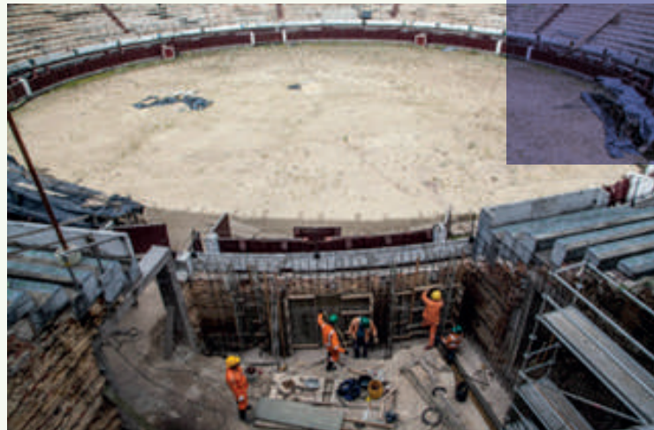
Obra de reforzamiento estructural en la Plaza la Santamaría. Fuente: IDPC.
