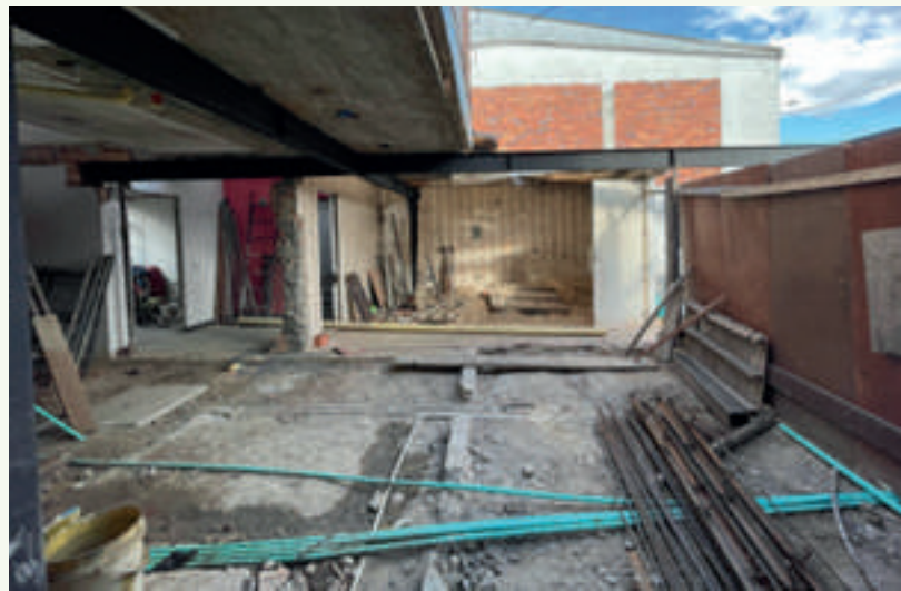
Foto 17. Fuente SCRCD Demolición parcial del primer piso de una vivienda localizada en el barrio Niza Sur.
