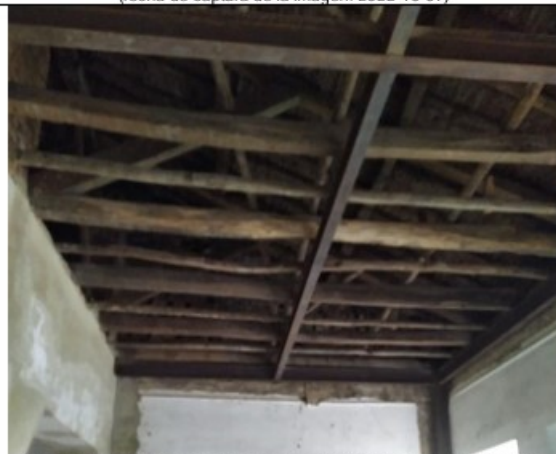
Fotografía 14. Estructura de cubierta con refuerzo estructural metálico bajo las piezas en madera, en el segundo piso del inmueble de la localizado en la CL 11 8 68 / 70 / 72 / 76, no se puede establecer de que época es esta intervención. (fecha de captura de la imagen: 2022-10-07)
