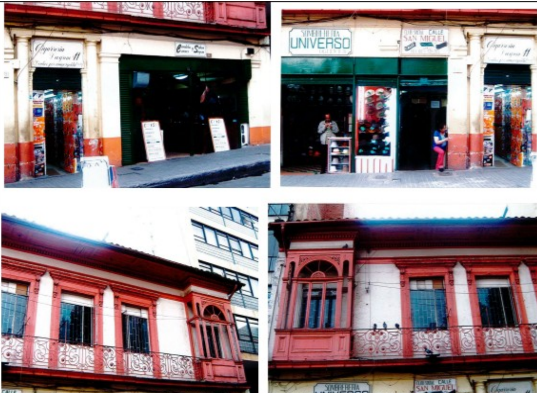
Fotografías del inmueble de la Calle 11 8 68/70/72/76, que evidencian el estado de la fachada en el año 2009. Fuente: Archivo IDPC. Radicado IDPC ER1173 del 24 de marzo del 2009.
