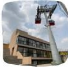
Centro Cultural Manitas (Ciudad Bolívar) Funcionamiento
